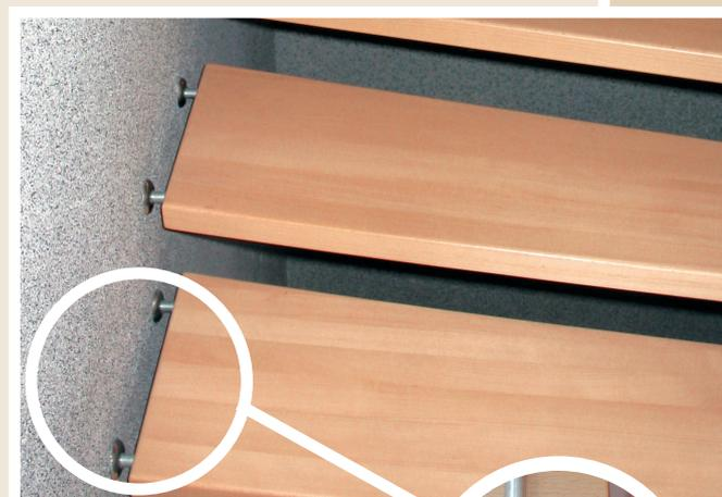
Wandbefestigung mit Wand- oder Schiebolzen, Gummilager, Krallenring und Abdeckrosette
