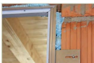
6. Tüorzarge in die Mauerleibung einsetzen und festschrauben. Falls nötig mit GELA-PUR ausschäumen.
