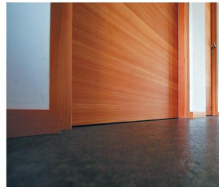
Bei den flächenbündigen Sockelleisten hat man sich das «Lego»-Prinzip in der Unterkonstruktion zu eigen gemacht. Alles basiert auf ausgereiften Steckverbindungen. Ob Innen- oder Aussenteile: Einfach aufstecken, befestigen und schon hat man die Unterkonstruktion für eine flächenbündige Sockelleiste.
