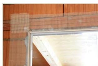
7. Putznetz in Profile einclippen.
